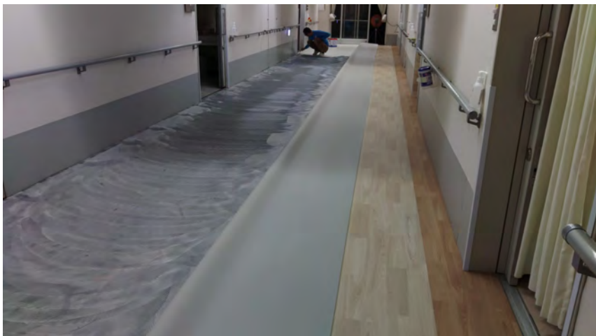
上張りシート施工状況 2024. 3. 24
