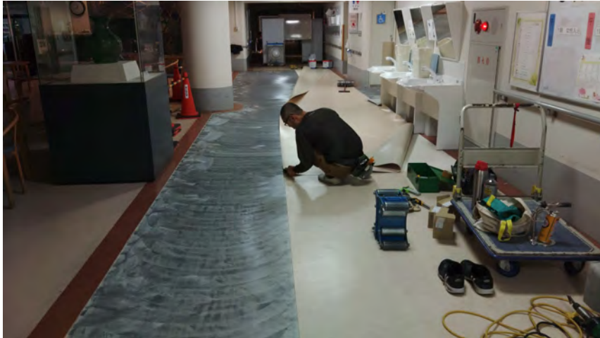
上張りシート施工状況 2024. 3. 28~29
