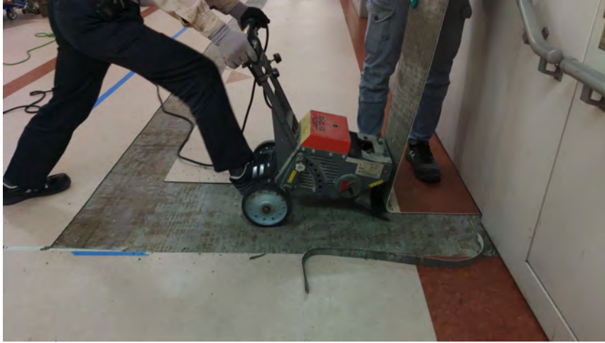
既存シート剥ぎ状況 2024. 3. 23
