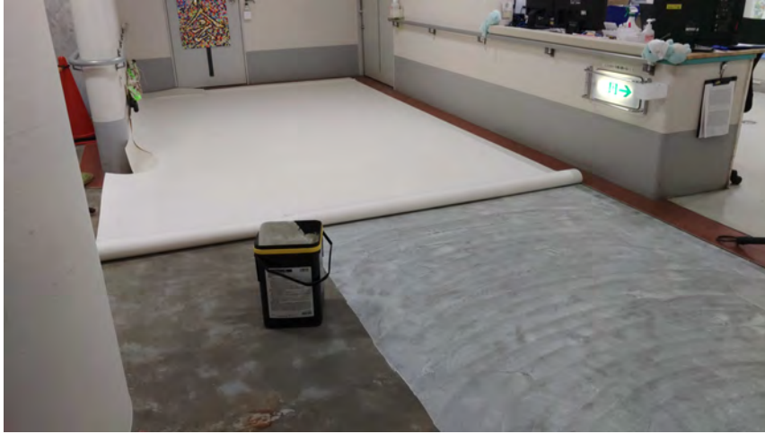
下張りシート施工状況 2024. 3. 27
