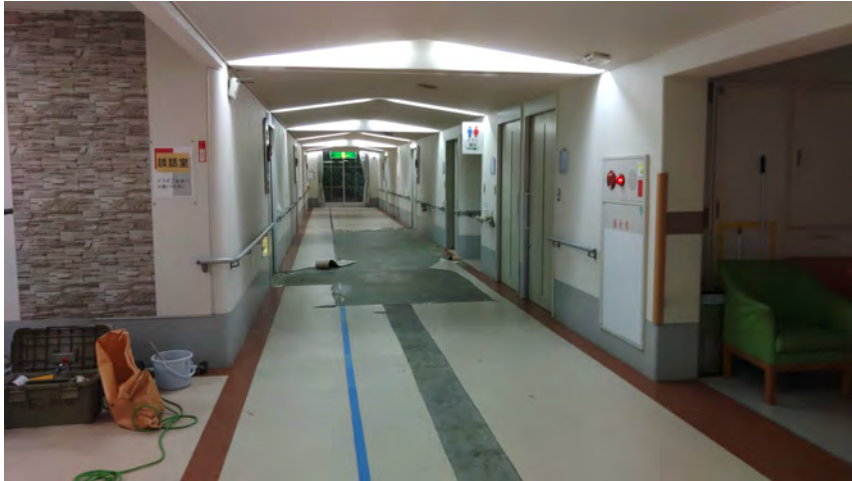
既存シート剥ぎ状況 2024. 3. 23
