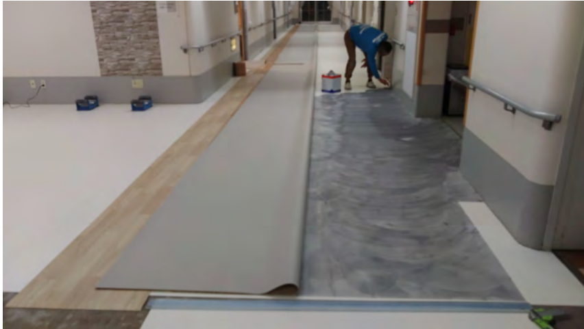
上張りシート施工状況 2024. 3. 24
