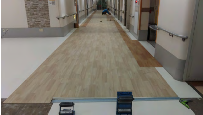
上張りシート施工状況 2024. 3. 24
