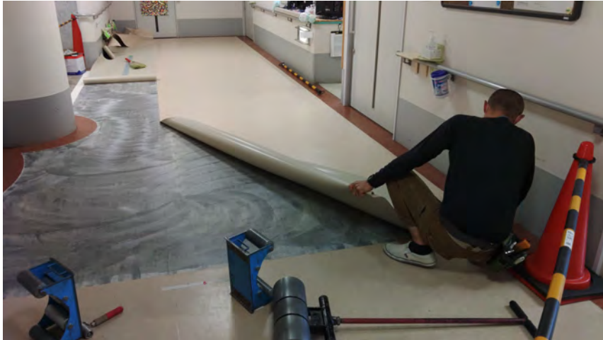
上張りシート施工状況 2024. 3. 27
