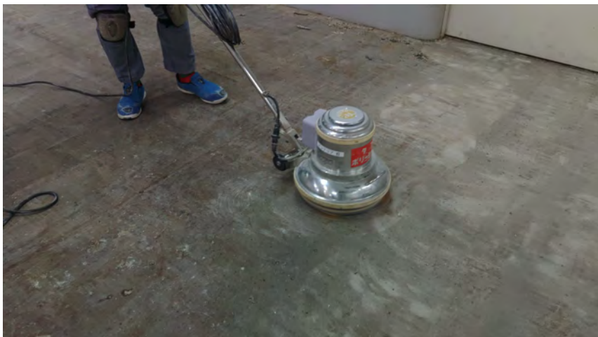
下地調整状況 2024. 3. 23
