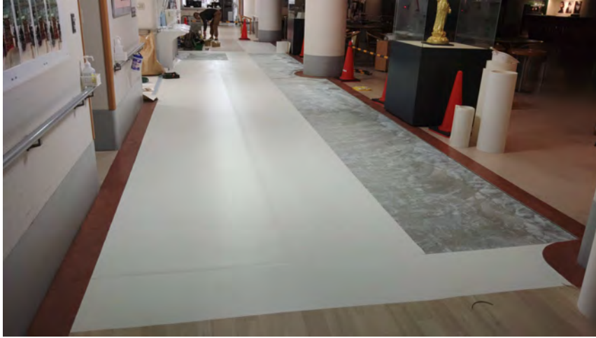
下張りシート施工状況 2024. 3. 28~29
