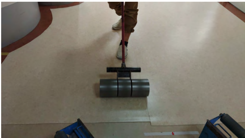
上張りシート施工状況 2024. 3. 27
